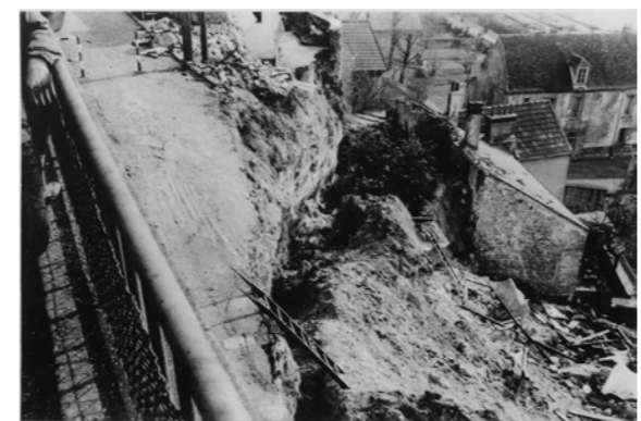
Conflans, glissement terrain
