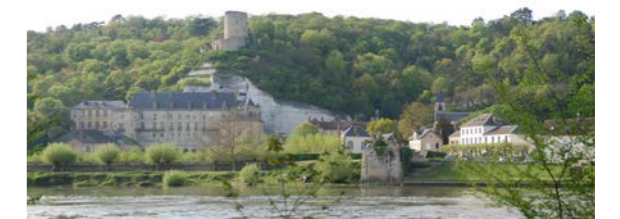
Le site de la Roche-Guyon (Val d'Oise)
