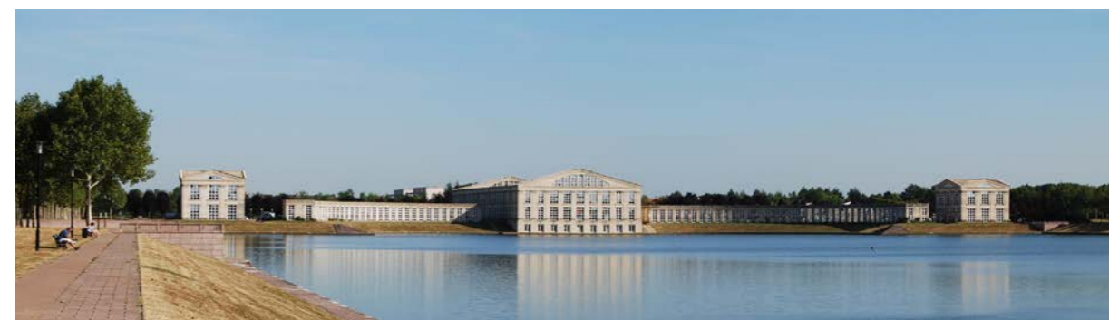
Le quartier du Lac, conçu par l'architecte Ricardo Bofill dans les années 80.
